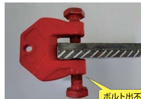
ボルト出不足
